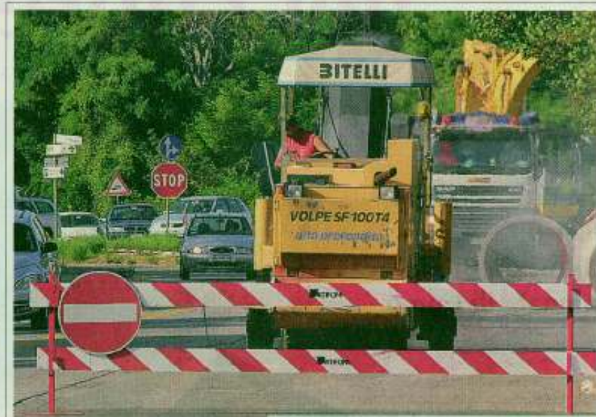
IL CANTIERE Partiti i lavori per la tangenziale
